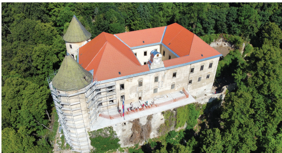
Grad je konec junija že gostil prve obiskovalce, ki so si ogledali, kaj vse je že bilo postorjenega.
